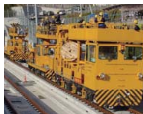
架線作業車（左奥）と架線延線車（右手前）
