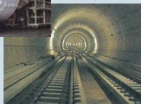
複線円形トンネル
